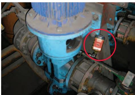
Lubricación de una bomba de combustible en el proceso de refinado
