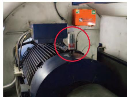
Relubricación automática del cojinete del generador
