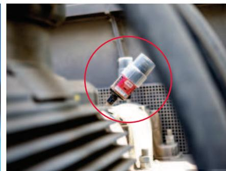
Lubricación del cojinete de un ventilador
