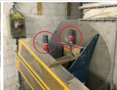
Lubricación del cojinete de un ventilador
