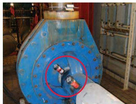
Lubricación del árbol de transmisión de una bomba
