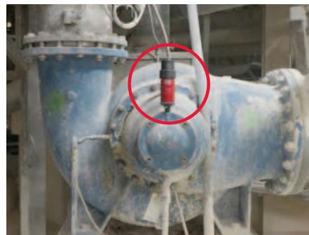
Lubricación del cojinete de una bomba
