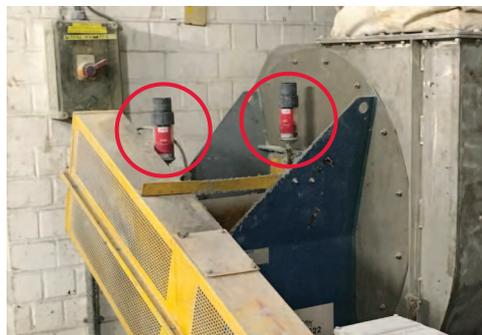
Lubricación del cojinete de soporte de un ventilador
