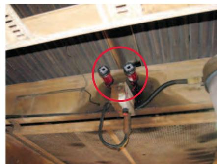
Lubricación del ventilador (Fin Fan) de una instalación de intercambio de calor
